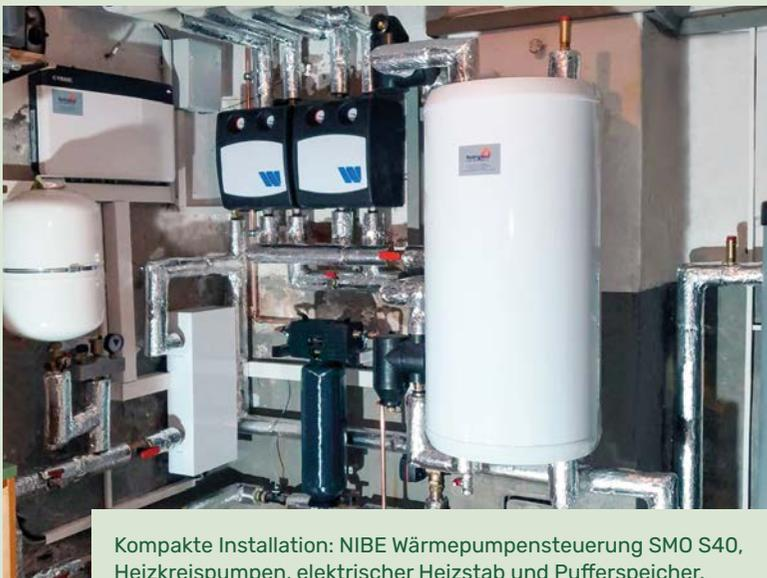
Kompakte Installation: NIBE Wärmepumpensteuerung SMO S40, Heizkreispumpen, elektrischer Heizstab und Pufferspeicher.
